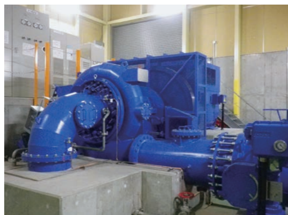
写真2 横軸フランシス水車
