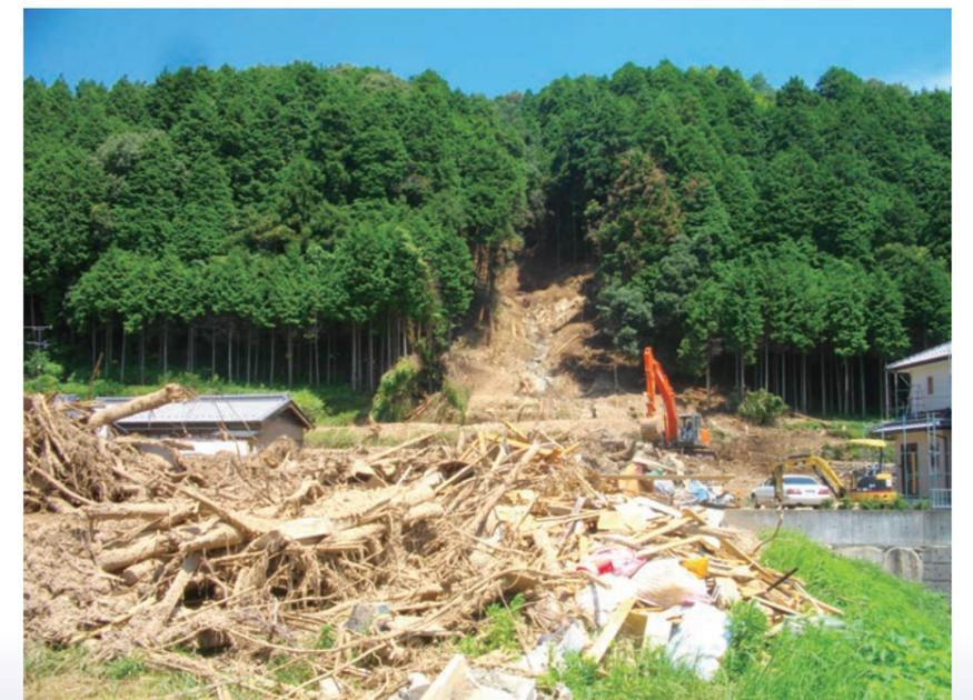
写真3 都市近郊で沢の出口に新築された人家が土石流で被災
