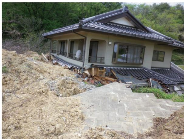
写真1 東日本大震災時に斜面崩壊で被災した人家(2011年3月)
