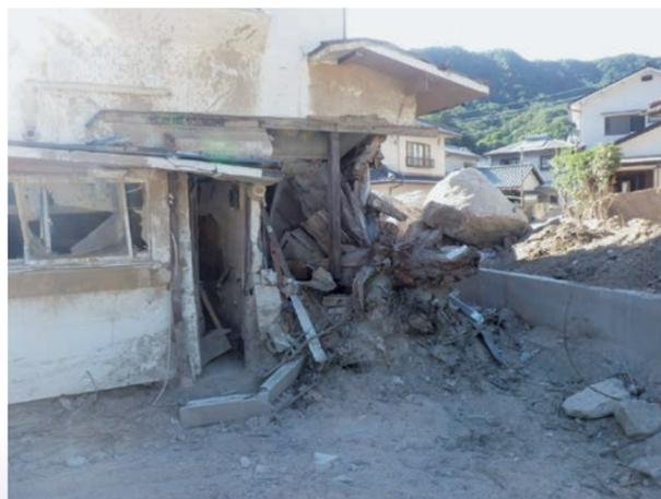
写真2 西日本豪雨災害時に土石流で被災した人家(2018年7月)
