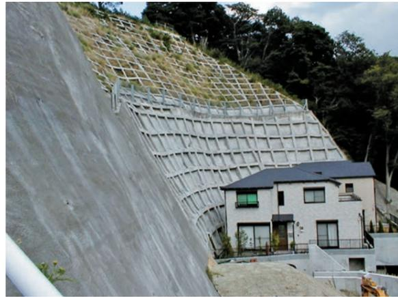
写真4 斜面災害を防止する急傾斜地ハード対策工例
