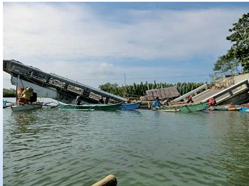
ボホール地震被害(落橋)
