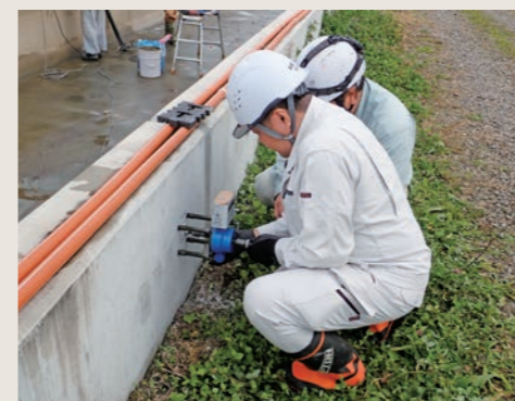
用水路機能診断調査
