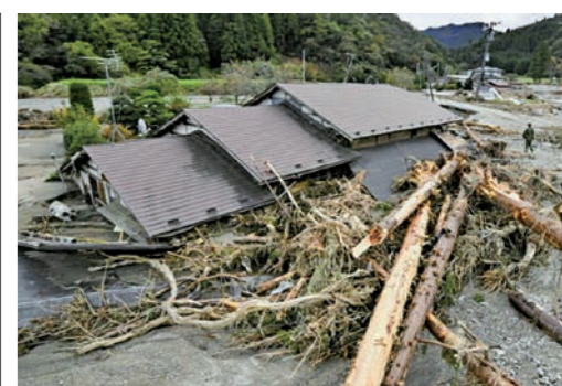
写真2 宮城県丸森町の五福谷川流域での洪水・土砂・流木の流出による被災状況(令和元年12月1日筆者撮影)
