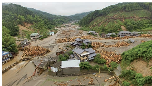
写真1 福岡県朝倉市の赤谷川被害箇所(平成29年7月7日15時30分撮影)(出典:国土地理院)
