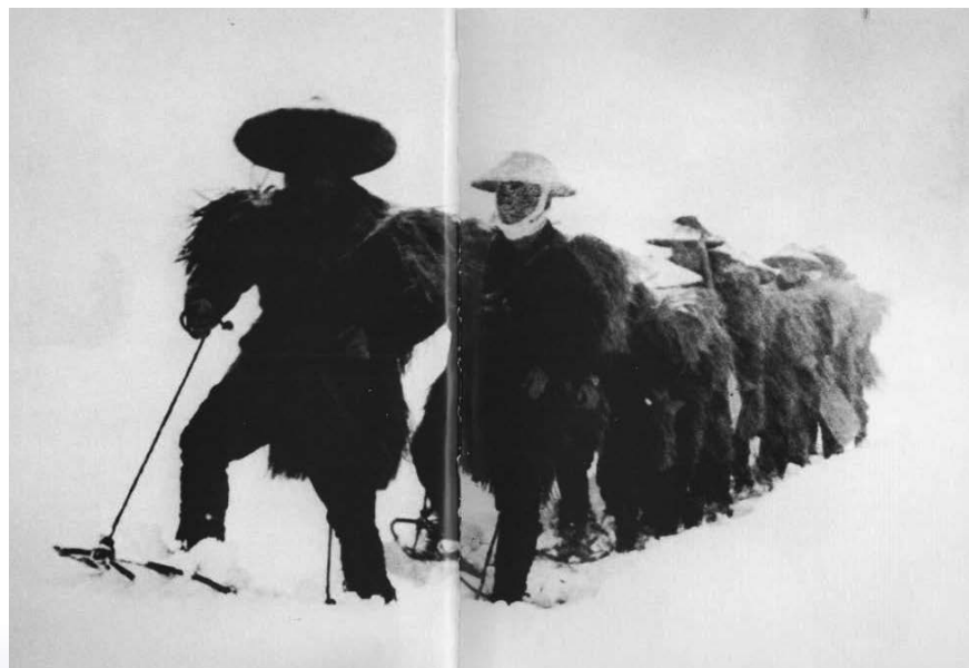
写真1 道踏み（左）早朝の雪踏み（人力による生活道路確保）。（右）集落間をつなぐ道踏み（人力による基幹道路確保）。(『豪雪譜』日本積雪連合発行より転載)
