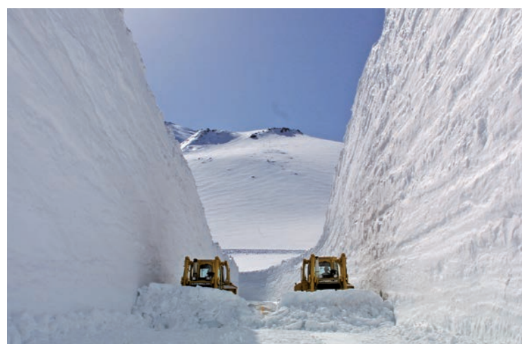
「雪の大谷」のブルドーザ2台による雪壁を切り下げる除雪の様子
