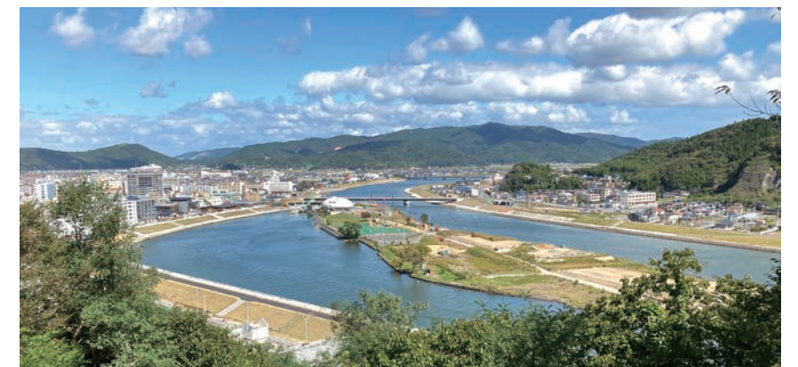
堤防整備が概成した現在の旧北上川河口部の状況
