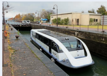
③閘室の水位を下げる
