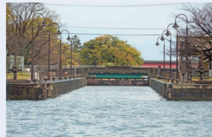
①閘室内に注水し上流側門扉を開放する
