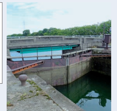
中島閘門の下流側門扉
