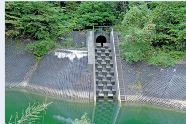
取水トンネルの放流口
