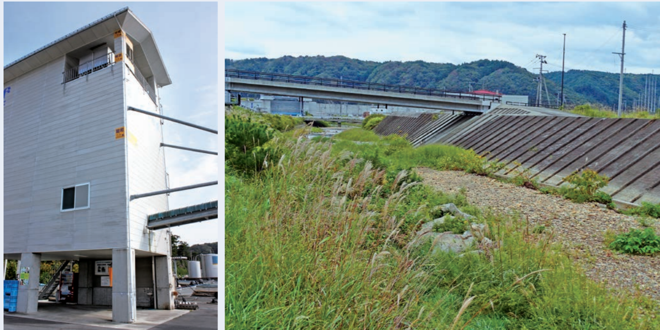
漁港に記された昭和、明治、平成の津波到達高 長内川沿いに延びる防潮堤
