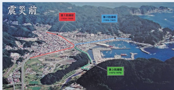
震災前の防潮堤配置(三王眺望公園看板より)
