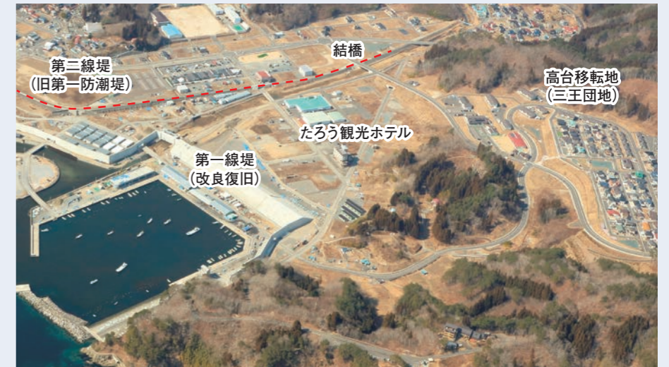
改良復旧された防潮堤と高台移転地（提供写真に著者加筆）
