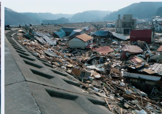
震災直後の第一防潮堤内
