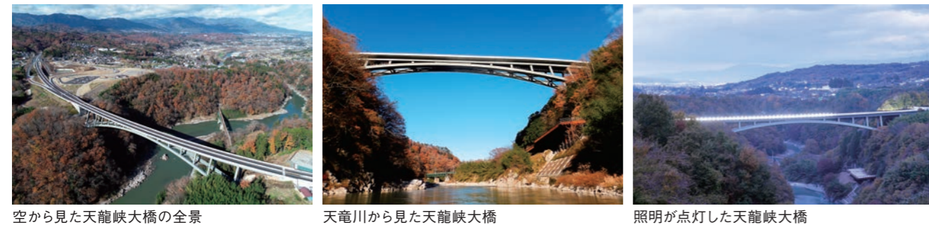
空から見た天龍峡大橋の全景
