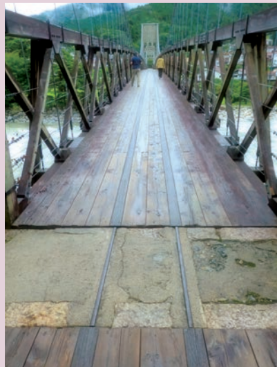
トロッコレール跡を模した桃介橋の橋面
