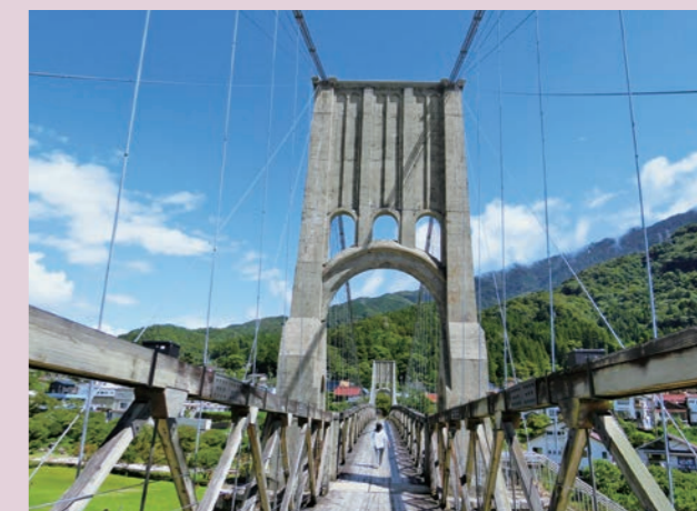
特徴的なデザインの主塔と大人の背丈ほどの高さの補剛トラス
