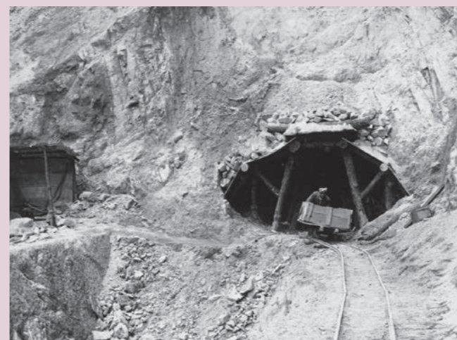
手掘りでのトンネル工事
