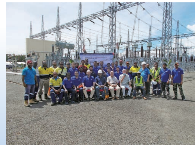
完成した変電所
