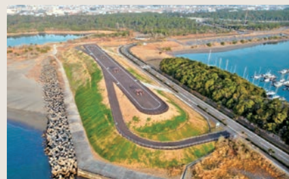
津波避難施設 / 宮崎港
