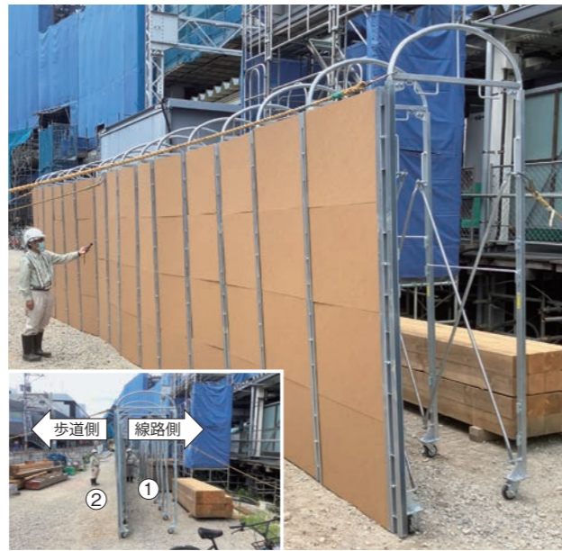
写真5 騒音測定試験状況
