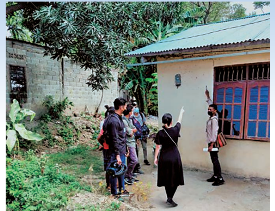
住宅に残る浸水した跡
