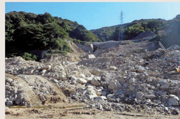
西日本豪雨災害の状況 (広島県呉市)
