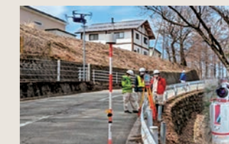
地上レーザ測量
