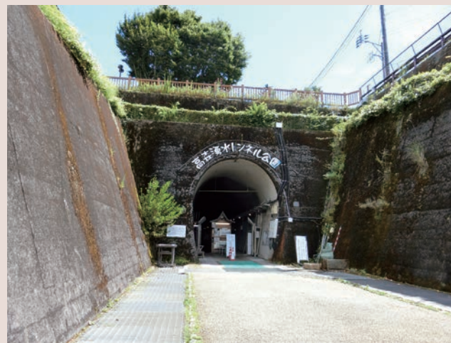
トンネル坑口
