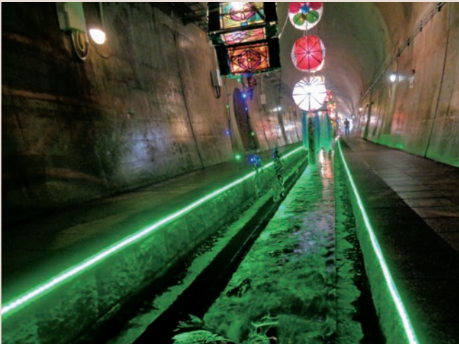
トンネル坑内の「七夕飾り」
