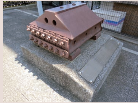
霞橋脇の鳶色の支承
