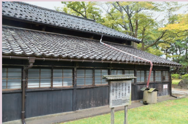
風通しをよくし低温管理に貢献した山居倉庫の二重屋根
