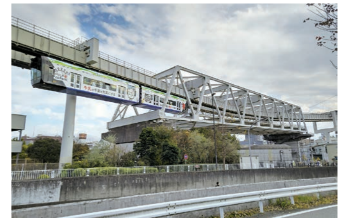
JR総武本線を跨ぐトラス橋
