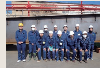
七味温泉橋仮組見学
