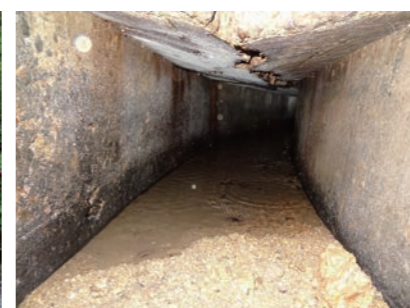
導水路 (改修前)
