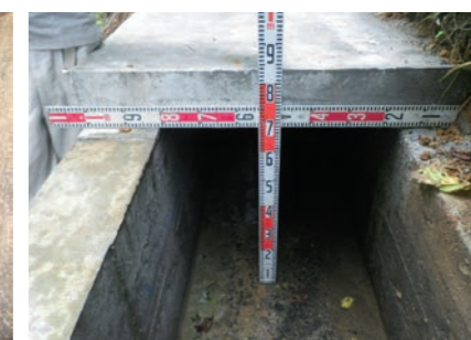
導水路 (改修後)
