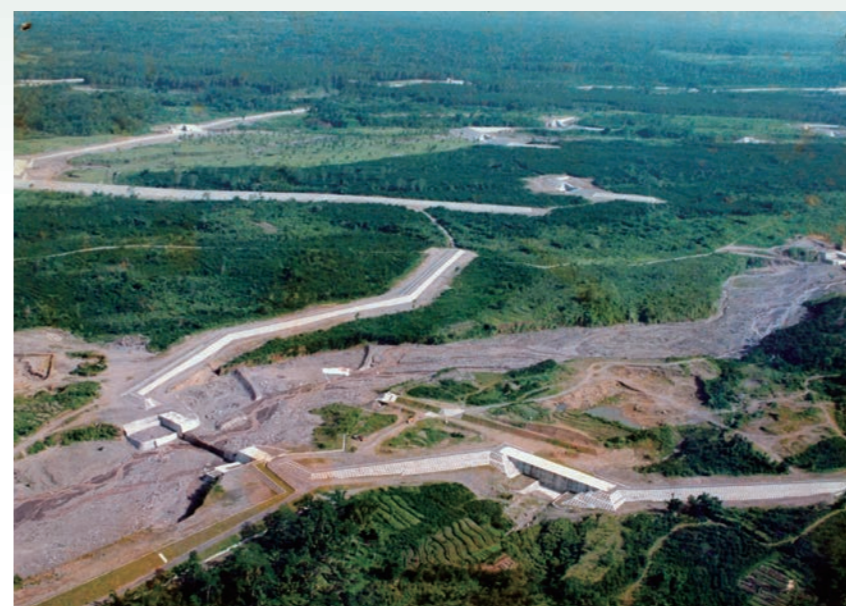
写真3 1980年代に円借款事業で建設された砂防施設 4)
