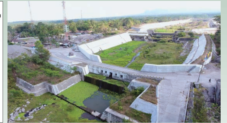
写真6 砂防堰堤と導流堤からなるゲンドール川のサンドポケット
