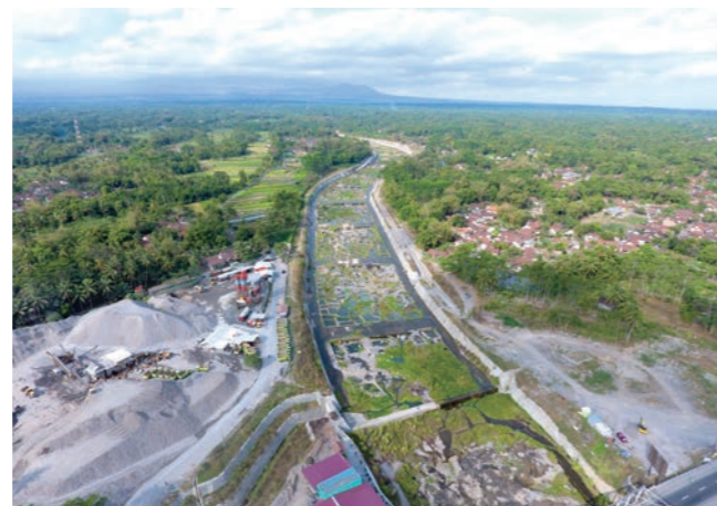
写真5 完成したプティ川の河道改修部分
