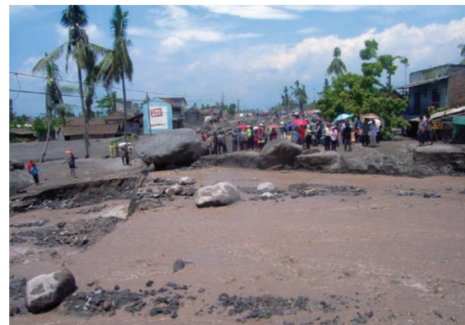
写真4 国道を埋め尽くした土石流堆積物 4)
