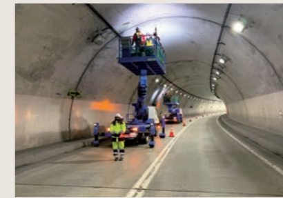
トンネル点検
