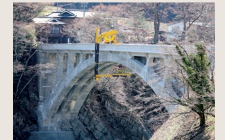
重要文化財【坂戸橋】橋梁点検
