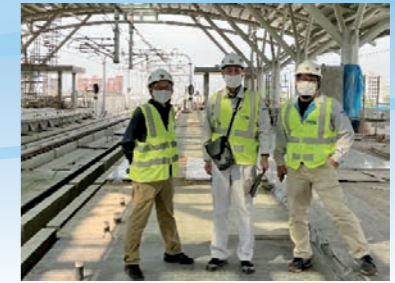
写真1 建設現場の様子(ダッカ都市交通整備事業)
