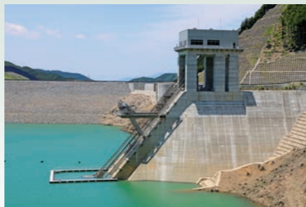
写真4 選択取水設備
