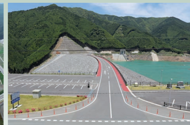
写真2 小石原川ダム曲線軸
