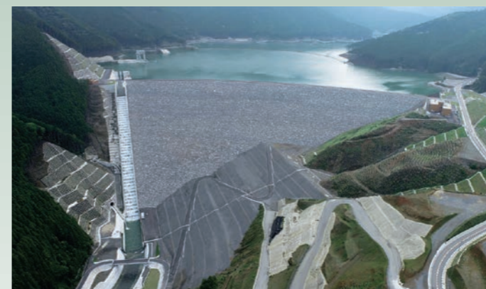
写真1 小石原川ダム全景 1) （試験湛水時2021年5月22日撮影）
