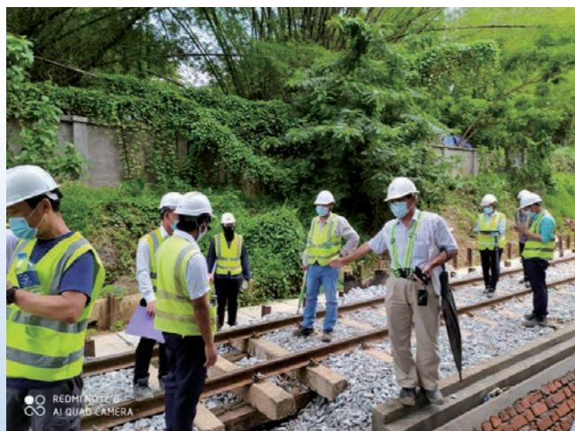
写真7 コロナ期の工事現場(ヤンゴン環状線)
