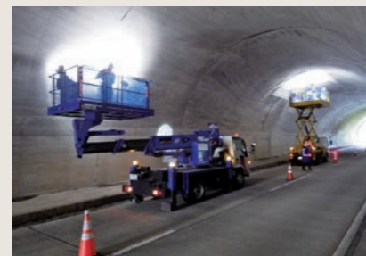
トンネル点検/和田平トンネル (大分県)
