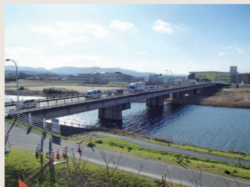
耐震補強設計/別保橋 (大分県)
