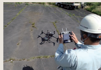
UAVレーザー作業風景
