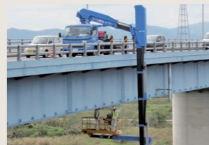
橋梁点検/松岡大橋 (大分県)
