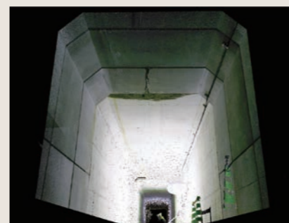
3Dスキャナーによるボックスカルバート内損傷調査
