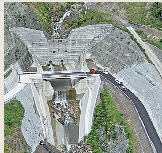
砂防堰堤のドローンによる空撮
