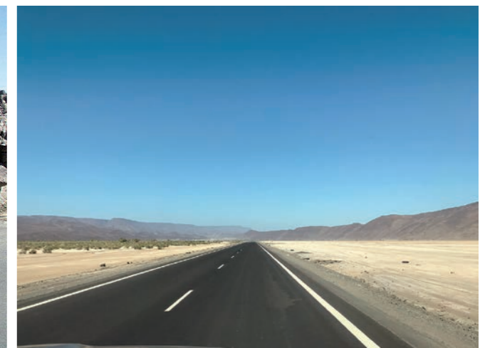
写真4 完成し供用直前の国道1号
