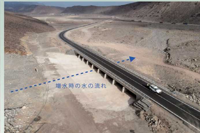
図4 完成後のガラフィ・ワジの渡河構造
