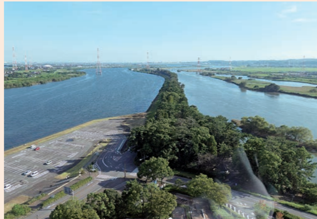
宝暦治水と三川分流工事によって造られた油島締切堤
