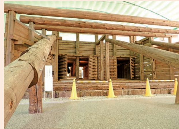
復元された金廻四間門樋
