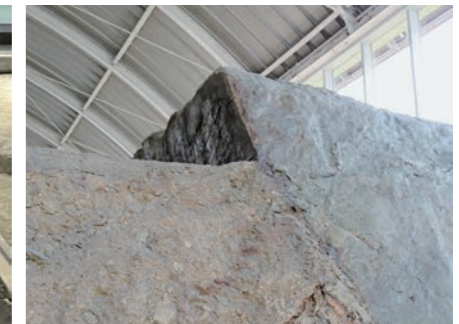
トレンチ部からの野島断層
