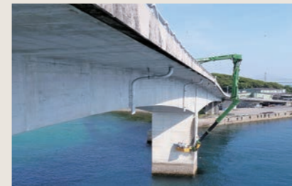
橋梁点検車による点検
