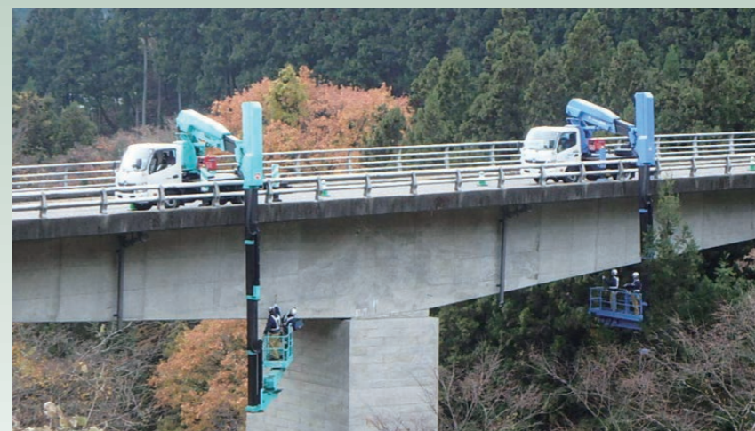
写真3 橋梁点検の様子
