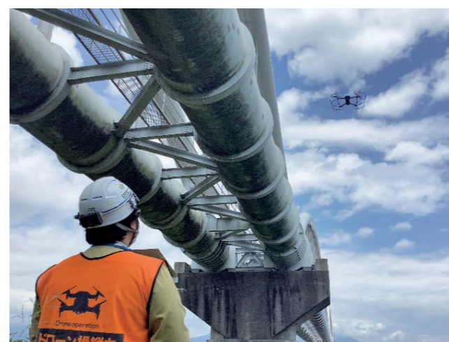
写真4 ドローンによる点検の様子
