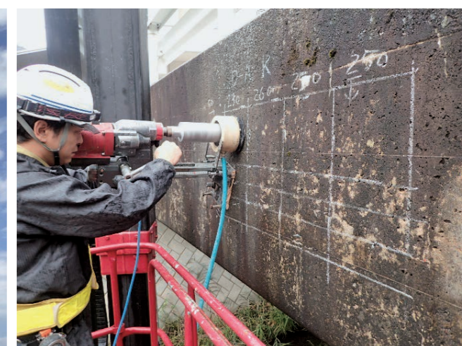
写真5 コア抜きの様子
