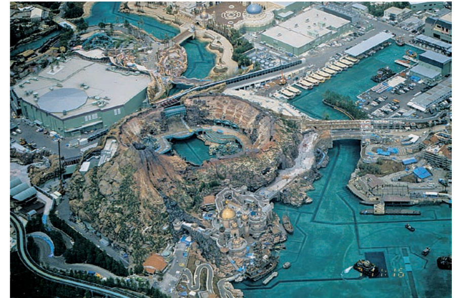
写真7 千葉県に建設中の人工火山 秋田→羽田、右側
