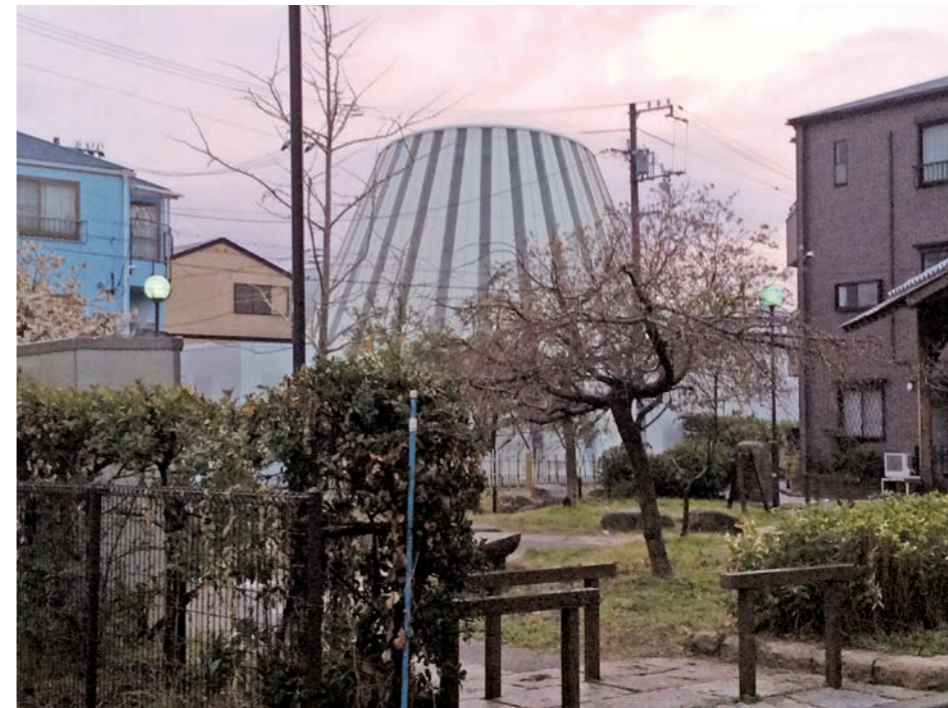
写真2 震災復興に積極的に関わった坂茂設計によるカトリックたかとり教会礼拝堂 (神戸市長田区)
