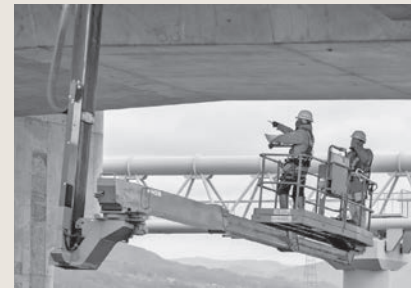
インフラ整備 点検1
