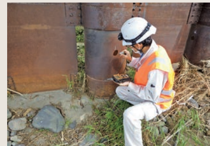
インフラ整備 点検3
