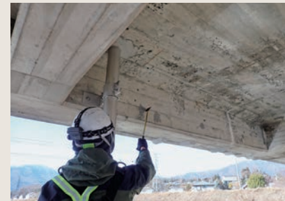
インフラ整備 点検2
