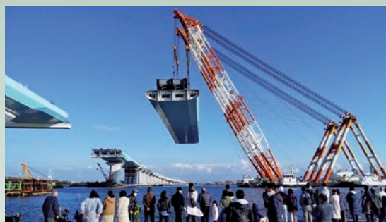
写真5 フローティングクレーン（海翔）による中央径間架設（橋桁の横断形状は11角形となっている）
