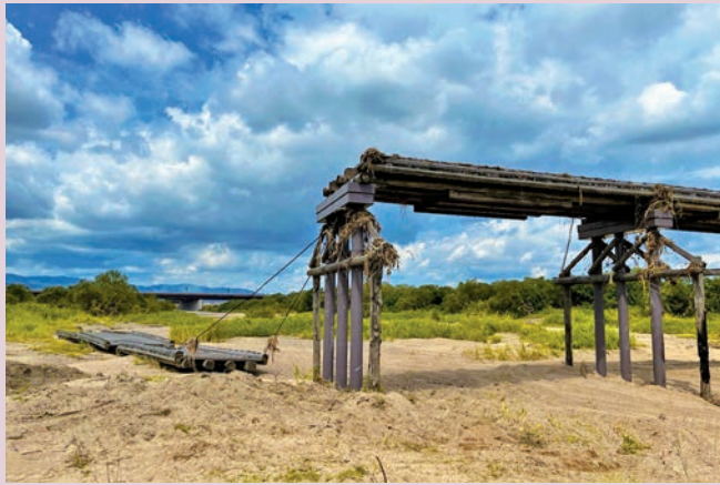
写真4 上部構造と下部構造がワイヤーでつながっている様子
