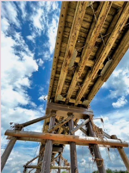
写真5 ユニット構造の様子(橋脚の真ん中3本はコンクリート製)
