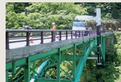
保有点検車による橋梁点検
