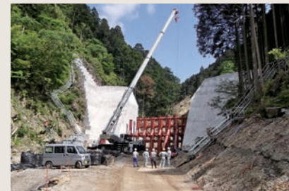
奈良県麦谷川透過型砂防えん堤
