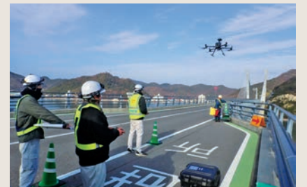
日生大橋 ドローンによる橋梁調査
