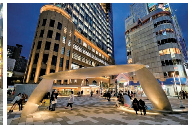
写真3 完成写真 サンキタ広場
