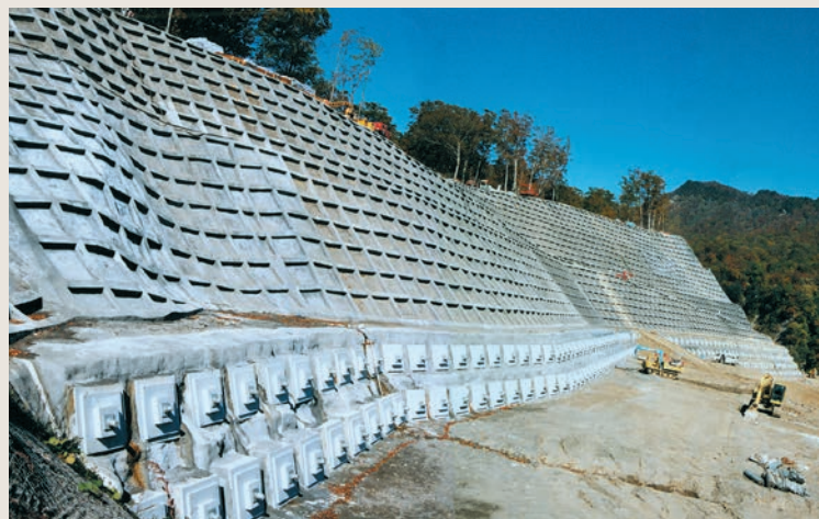
アンカー工・のり枠工
