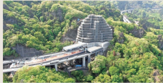
上信越自動車道 佐久管内施工管理業務（北野牧工事）
