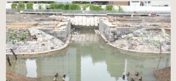
高輪築堤跡第7橋梁橋台部近景（国指定史跡）
