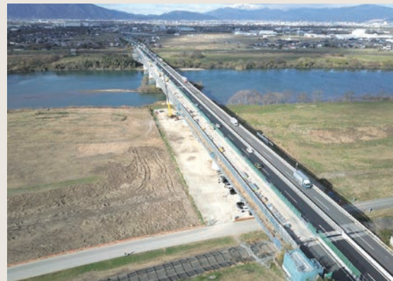
羽島管内特定更新等工事土木施工管理業務（長良川橋床版取替工事）
