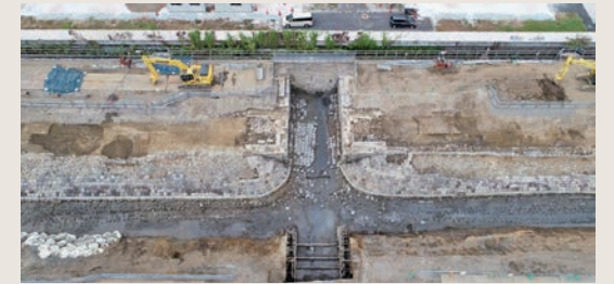
高輪築堤跡第7橋梁橋台部全景（国指定史跡）
