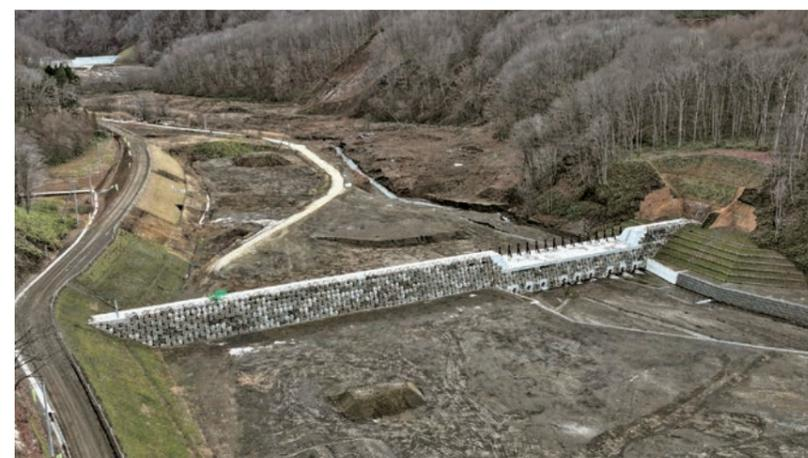
写真4 応急対策のコンクリートブロックを活用した恒久対策砂防堰堤 (北海道開発局HP、<https://www.hkd.mlit.go.jp/mr/kouhou/c5b1ee00000f4qa.html#s1>)
