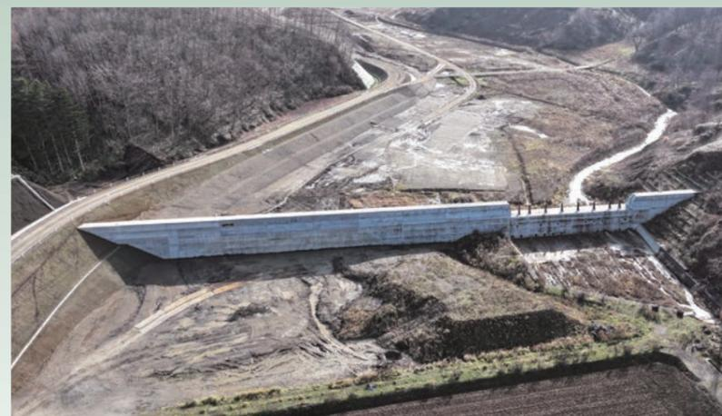
写真3 砂防堰堤の完成 (恒久対策) (北海道開発局HP、<https://www.hkd.mlit.go.jp/mr/kouhou/c5b1ee00000f4qa.html#s1>)
