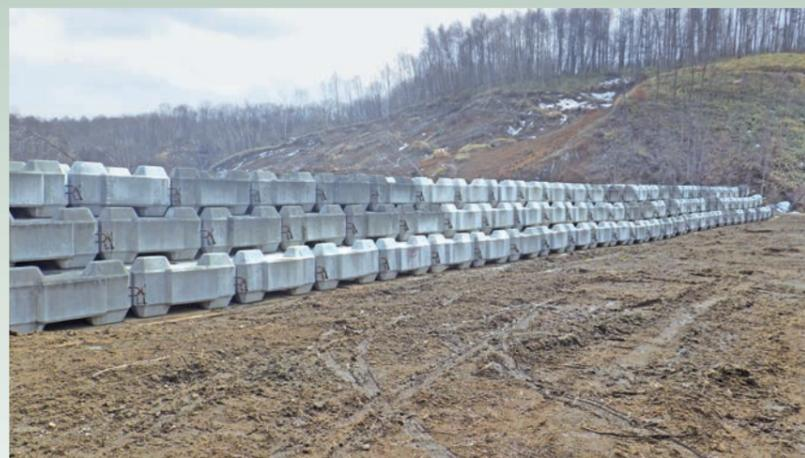
写真2 ブロック積砂防堰堤 (応急対策)
