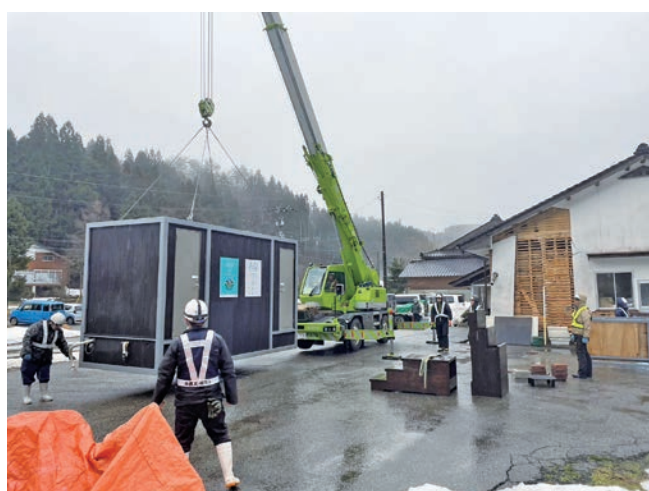
写真1 能登町避難所へのA.Qトイレ設置の様子
