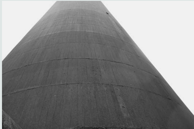
写真3 3号無線塔の型枠の跡
